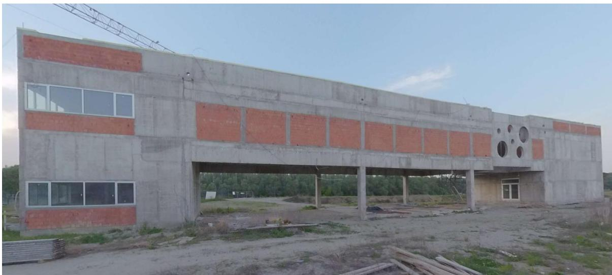
**LIMARSKI RADOVI** – Na objektu nisu održani limarski radovi. Potrebno je odraditi sve limene opšave i vanjske prozorske klupčice u skladu sa projektom.
