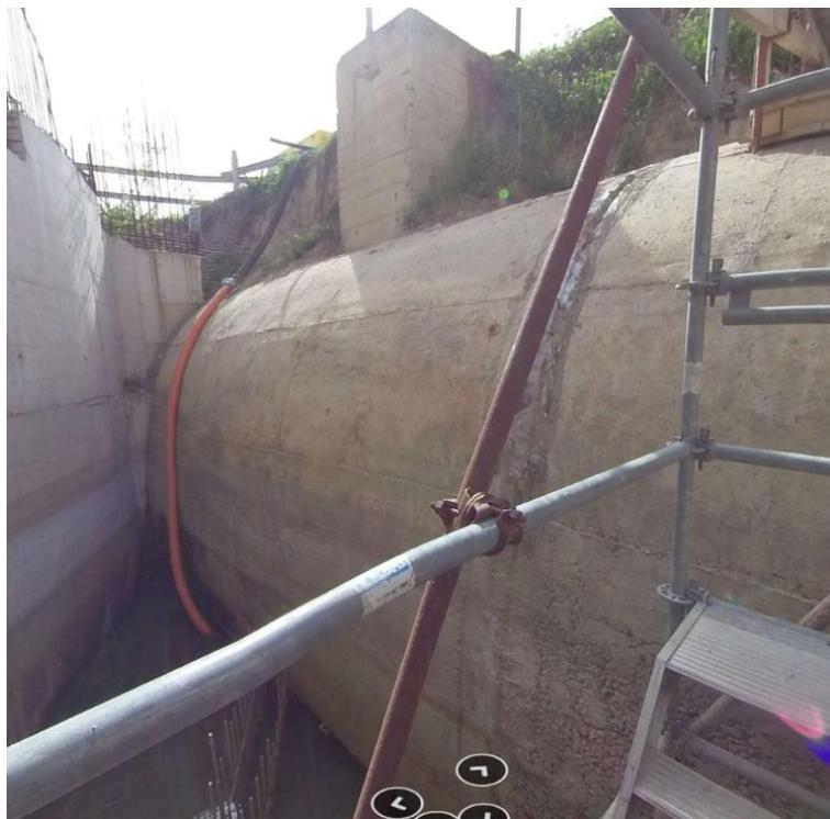
**BETONSKI RADOVI** – izvedeno cca 50% podložnog betona. Potrebno izvesti podložni beton ispod dijela ploče koji nije izведен.
