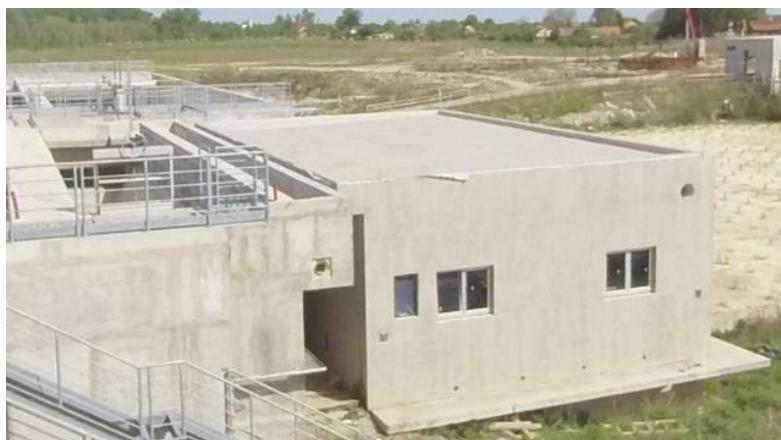
**FASADERSKI RADOVI** - Na građevini komore uklanjanja pjeska održan je dio fasaderskih radova. Postavljena je toplinska izolacija (bez završnog sloja). Do gotovosti potrebno je ugraditi završni sloj akrilne žbuke u boji prema izboru investitora.
