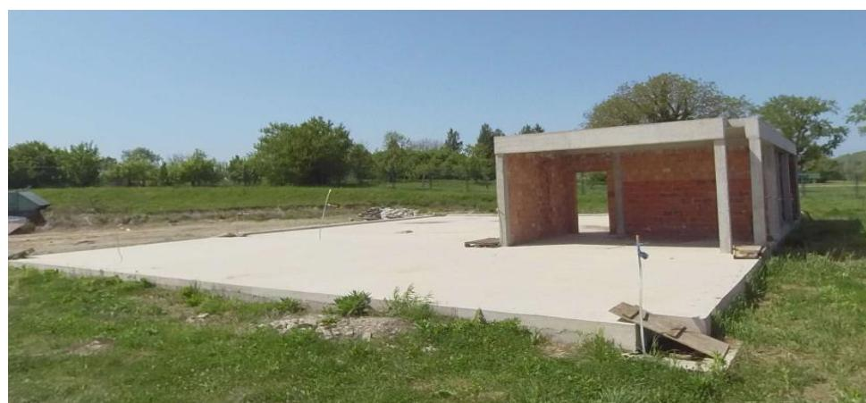
**ZEMLJANI RADOVI** - Na objektu radionice održani su svi zemljani radovi predviđeni projektom. Po završetku izvođenja svih radova izvesti zatrpanjanje zemljom iz iskopa na predviđenu kotu terena.
