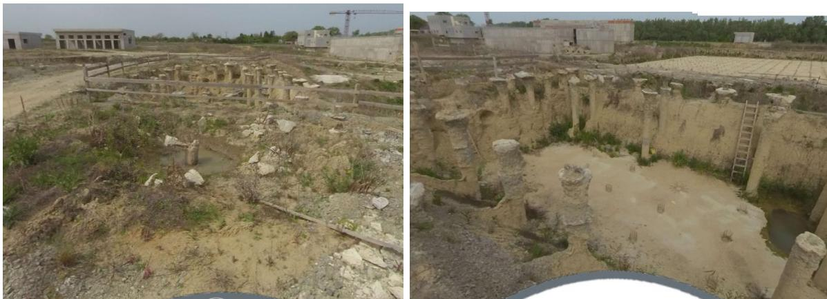
**GEOTEHNIČKI RADOVI** - Na objektu su izvedeni svi piloti predviđeni projektom. Prije nastavka radova potrebno je provesti djelomično razbijanje izvedenih pilota do projektirane visine.
