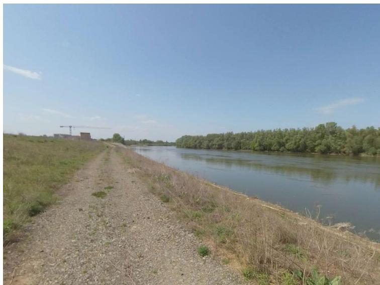
Iznad srednje bankine izveden je nasip sa nagibom pokosa 1:5 sve do kote 30 cm ispod završne kote obale koja je na 87,60 m n.m. Nagib pokosa je dodatno opremljen završnim slojem od humusa po kojem se tada zasijava trava za ozelenjivanje pokosa.
