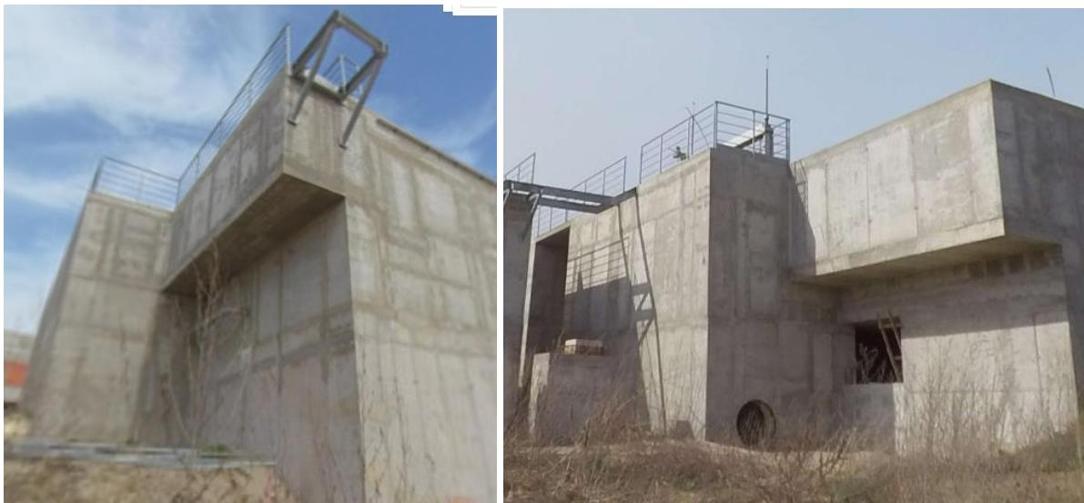
**LIMARSKI RADOVI** - Na objektu primarni taložnik nisu odrađeni limarski radovi predviđeni projektom. Potrebno je obložiti krovne plohe nadstrešnice čeličnim PU panelima.
