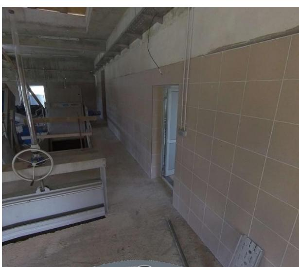
MONTAŽERSKI RADOVI – potrebno je ugraditi spojnice za ubetoniravanje GRP cijevi te sustav cijevi za ventilaciju
