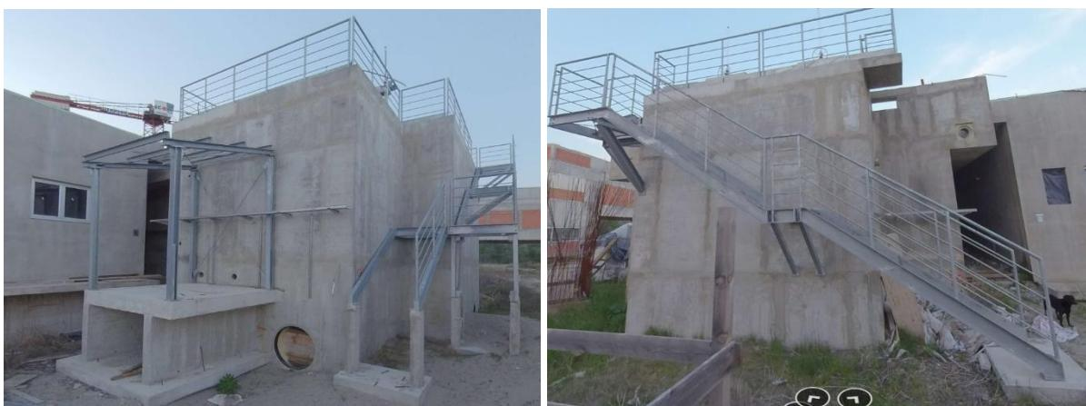
**LIMARSKI RADOVI** - Na objektu fine rešetke nisu održani limarski radovi predviđeni projektom. Potrebno je obložiti krovne plohe nadstrešnice čeličnim PU panelima.
